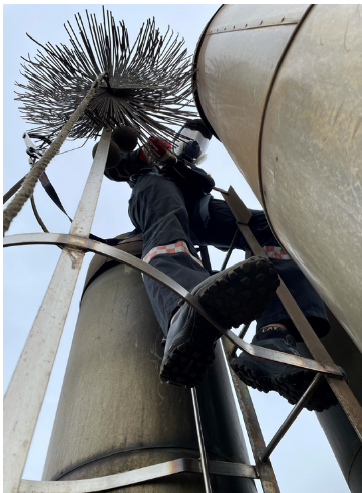
Feiing av den 70 meter høye pipa på Fjell i september.
