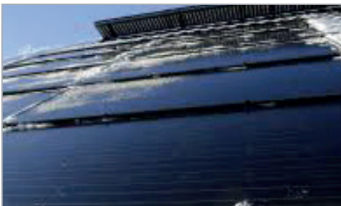
INTEGRERT FELT PÅ TAK SOM KAN SE UT SOM VINDUER NEDENFRA
