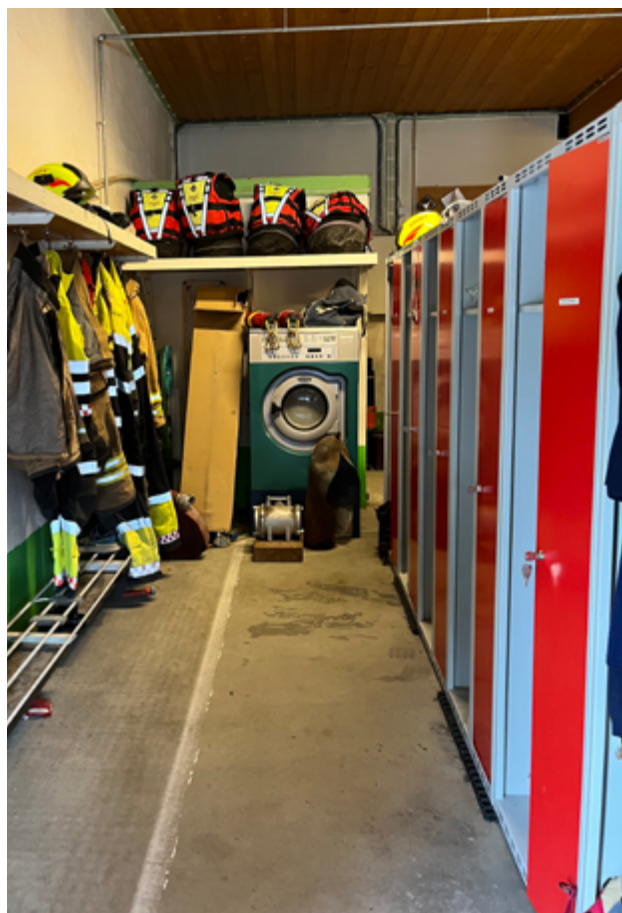
Brannstasjonen ved Noresund er gammel, og oppfyller blant annet ikke kravene til ren/skitten sone og garderobefasiliteter.
