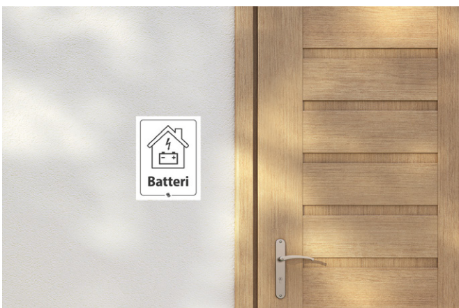
Eksempel på merking av bygg med batteriinstallasjoner.
